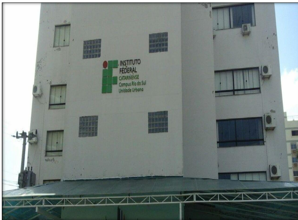
Figura 5 - Campus do IFC-SC zona urbana. Local de realização da ECN. Fonte: Site : < http://www.ifc-riodosul.edu.br/site/unidade-urbana >
